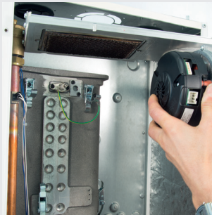
Az égő egység eltávolítása
