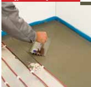
Kiegyenlítő réteg felhordása
