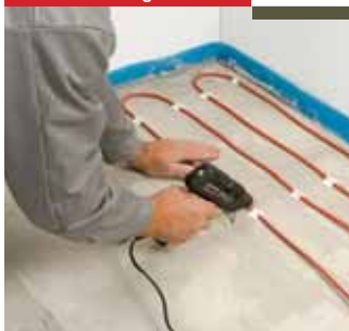
Fűtőkábel rögzítése
