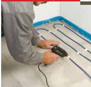
Fűtőkábel installációja
