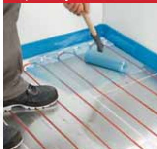
Alapozó hengerrel történő felvitele
