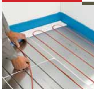
A fűtőkábelek fektetése
