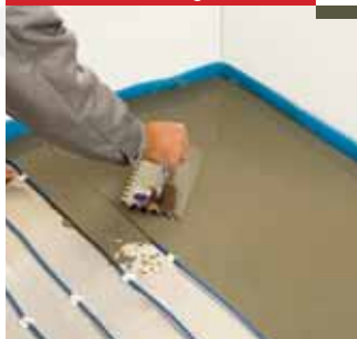
Esztrich-beton retag felhordása
