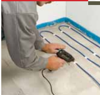
Fűtőkábel installációja
