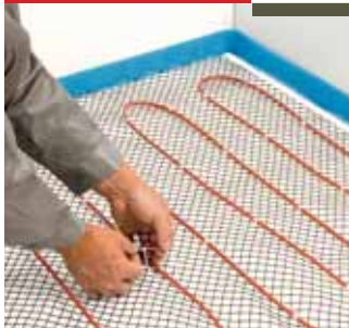
Fűtőkábel rögzítése
