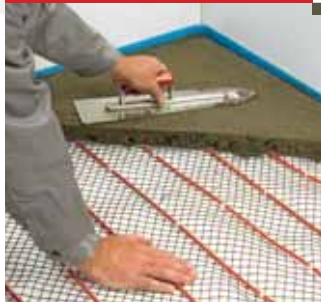
Esztrich-beton rétegi felhordása
