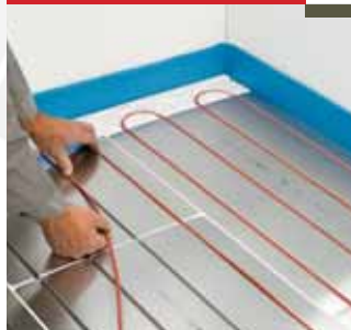
A fűtőkábelek fektetése
