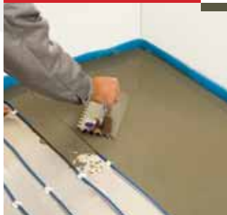
Kiegészítőréteg felhordása
